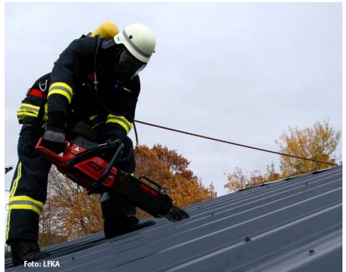
Einsatz der Rettungssäge zur Schaffung einer Abluftöffnung auf einem Dach
