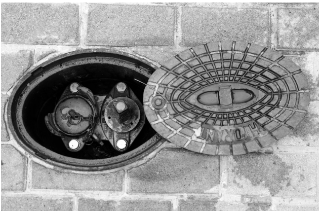
Geöffneter Hydrant
