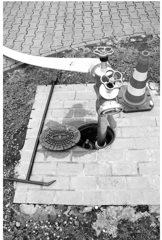
Gesetztes Standrohr
