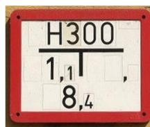
Da Unterflurhydranten schnell zugesperrt werden können oder von Schnee und Schmutz verdeckt werden, gibt es Hinweisschilder. Auf ihnen kann man die Entfernung des Hydranten zum Schild lesen. Wenn man vor dem Schild steht und es lesen kann, so ist die linke Zahl unter der Linie die Entfernung vom Schild in Metern nach links. Die rechte Zahl die Entfernung in Metern nach rechts. Die untere Zahl gibt die Entfernung direkt vom Schild an.
